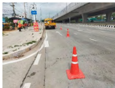
รูปที่ 7.2-1 ตัวอย่างการตั้งกรวยก่อนถึงบริเวณที่มีการปิดช่องจราจร
