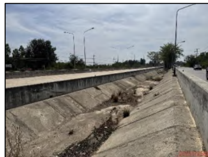
รางระบายน้ำตาดคอนกรีตเกาะกลางถนน
